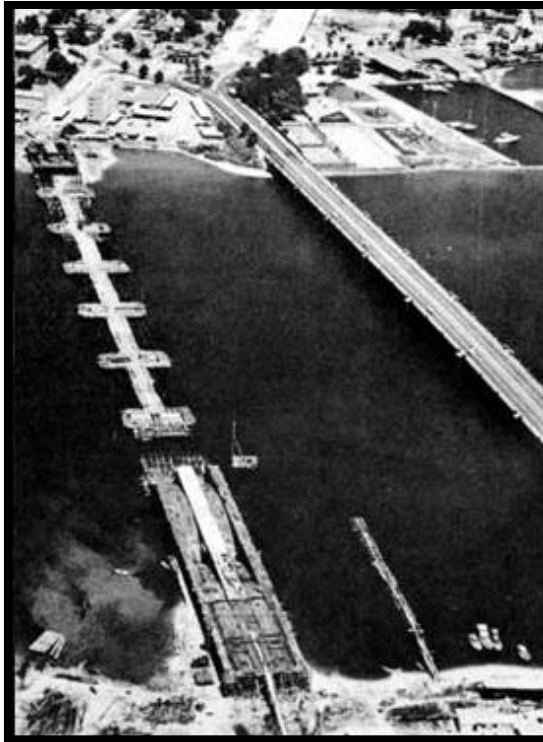
FIGURA 60: Construção da Ponte Governador Paulo Guerra.
