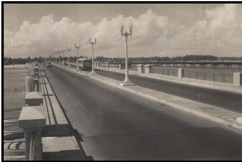
FIGURA 61: Ponte do Pina (atual Ponte Governador Paulo Guerra).
