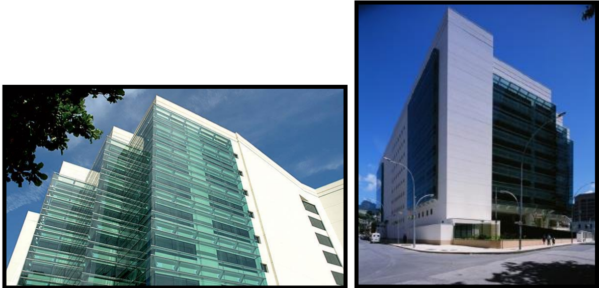
FIGURA 54 e 55: Vista da fachada norte e nordeste do Edifício Cidade Nova.
