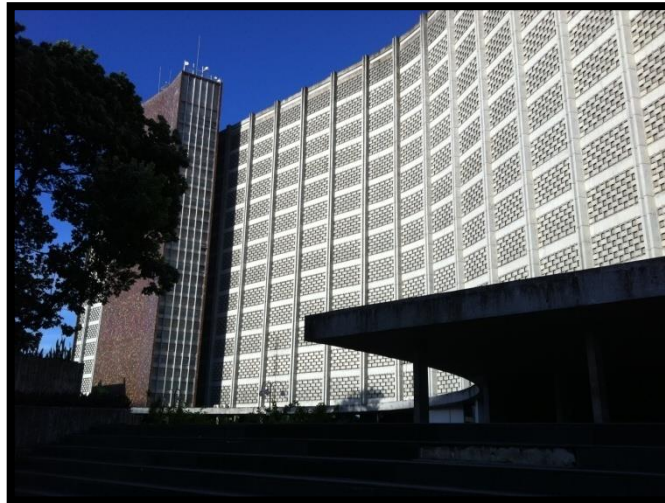
FIGURA 36: Vista da fachada oeste do Edifício da SUDENE.
