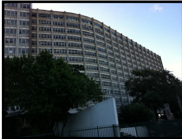
FIGURA 39 e 40: Vista da fachada leste do Edifício da SUDENE.
