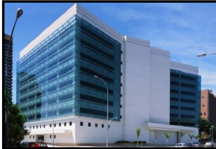
FIGURA 43: Vista da fachada sudoeste do Edifício Cidade Nova.
