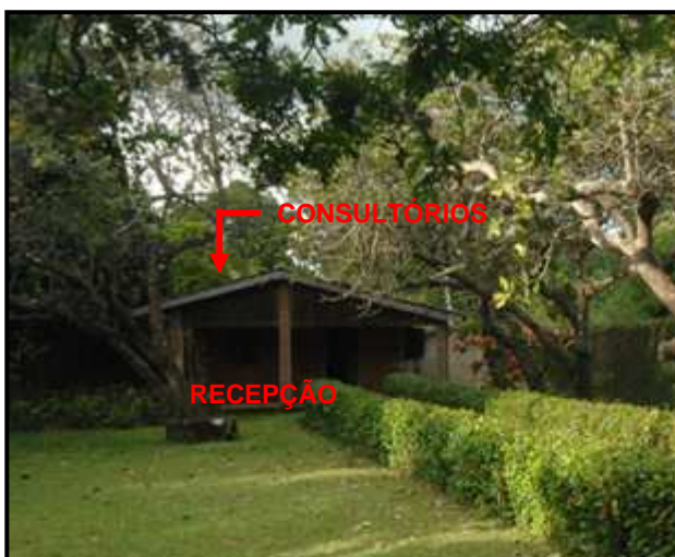
FIGURA 09: Vista externa do bloco com os consultórios.
