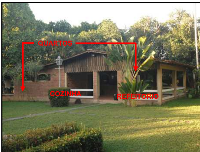
FIGURA 08: Vista externa do bloco03 (cozinha/refeitório/hospedagem).
