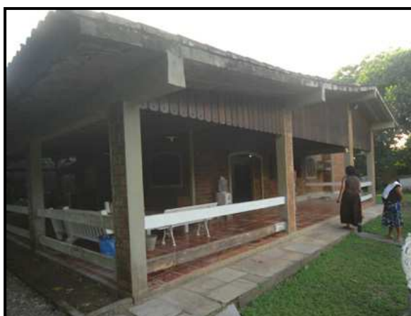
FIGURA 05: Vista externa da casa principal. FONTE: Juliana Selbman, 2011
