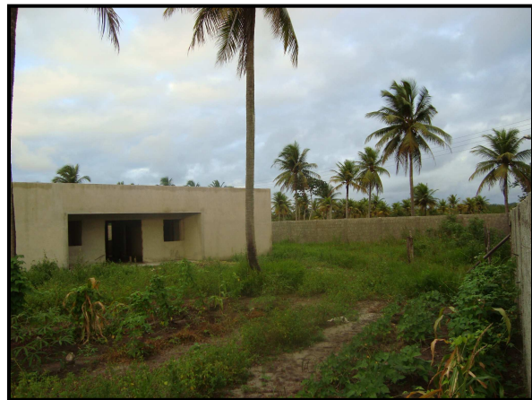
FIGURA 32: Vista interna do terreno (lado direito). FONTE: Acervo da Autora, 2011.
