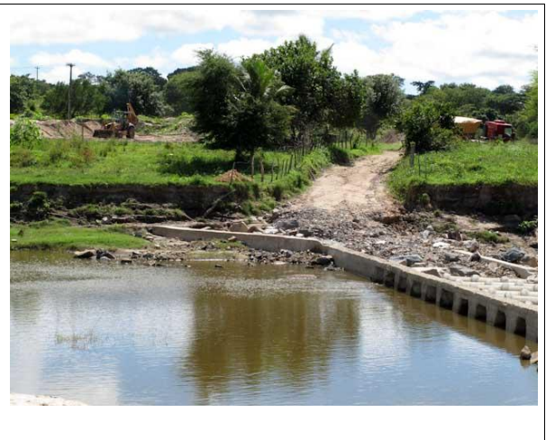
Figura 25: Trator movimentando areia num terreno na Barra do Riachão (no alto, à esquerda), mesma localidade da foto anterior. No alto, à direita, caminhão carregado de areia manobra na saída do terreno. Em primeiro plano, a passagem molhada parcialmente destruída pela enxurrada, após recuperação da inundação de 2010 (foto: do próprio autor).
