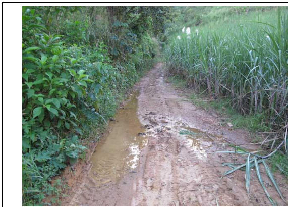
Figura 3: Água proveniente de resíduo de mata atravessa via local aberta em solo argiloso, ao lado de um canal. Município de Primavera, PE (foto: do próprio autor).
