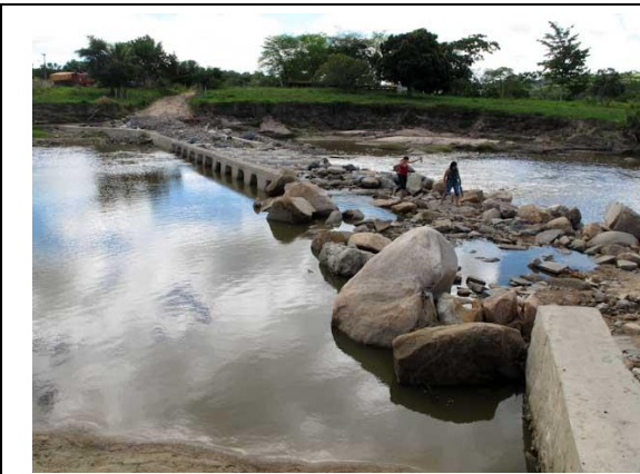
Figura 15: Passagem molhada da Barra do Riachão, destruída após a enchente de maio de 2011, em São Joaquim do Monte, PE (foto: do próprio autor).
