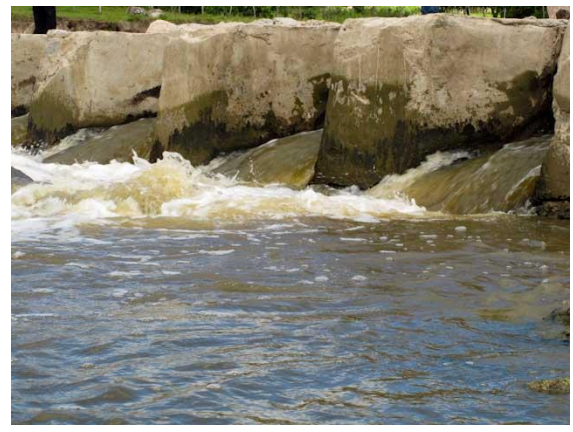
Figura 14: A água ganha energia ao passar pelas tubulações desses tipos de construções (foto: do próprio autor).
