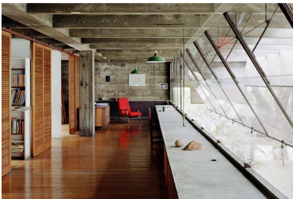
Figura 30 – Divisórias dos ambientes sem tocar o teto
