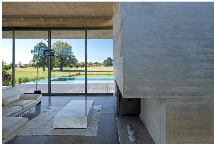
Figura 45 – Paredes de concreto aparente moldadas in loco
