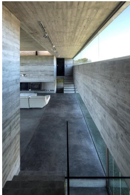
Figura 44 – Piso cimentício de acabamento liso
