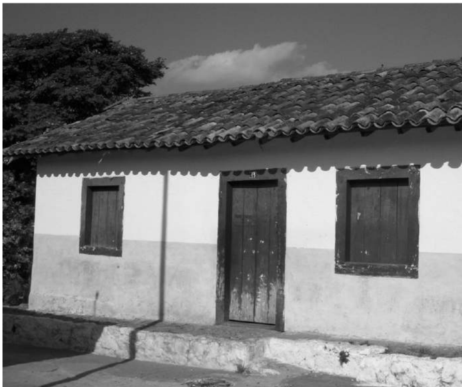
Figura 6 - Casa térrea em taipa de pilão, Carapicuíba, SP, área construída pelo Padre José de Anchieta para proteção dos índios.
